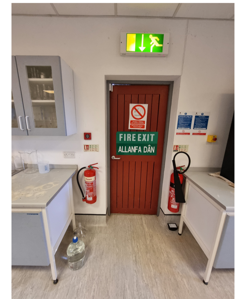
Existing External Door
